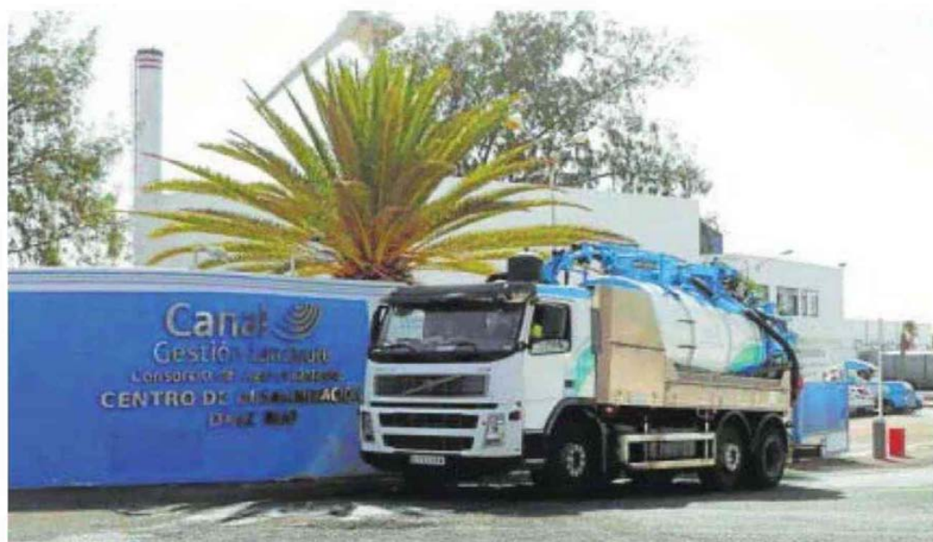
Exterior de las instalaciones de Canal Gestión Lanzarote, en Las Caletas, dedicadas a desalar agua. c7
