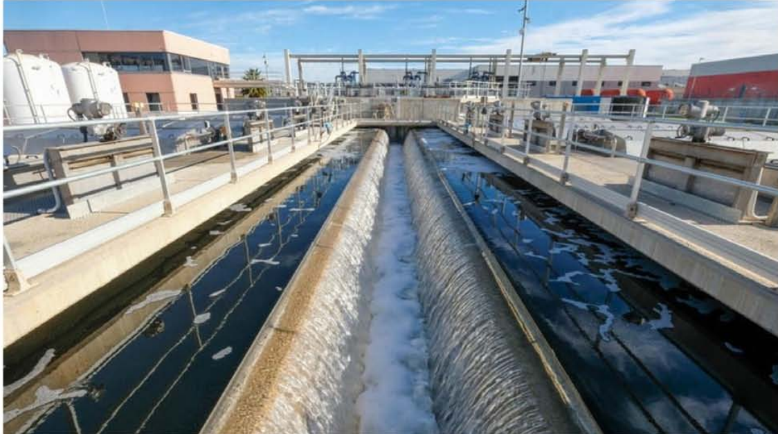
Tratamiento de agua en instalaciones de Agbar. / ACE
