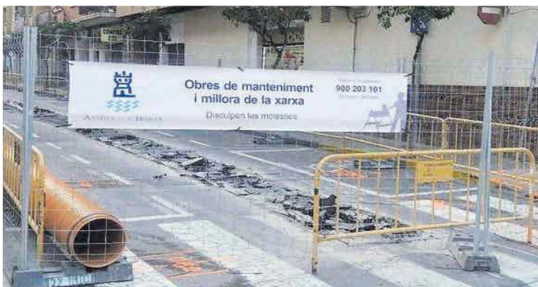
Unas obras de mejora de la red de agua realizada en uno de los municipios consorciados.
